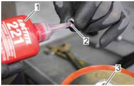
Abb. 49: Kleber auf Gewinde aufbringen
